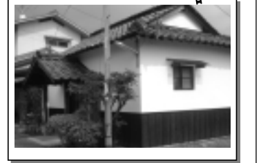
足守栄町公会堂の壁 塗り替え整備
