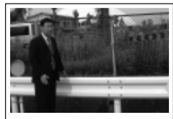
野田4丁目地内 転落防止柵設置
